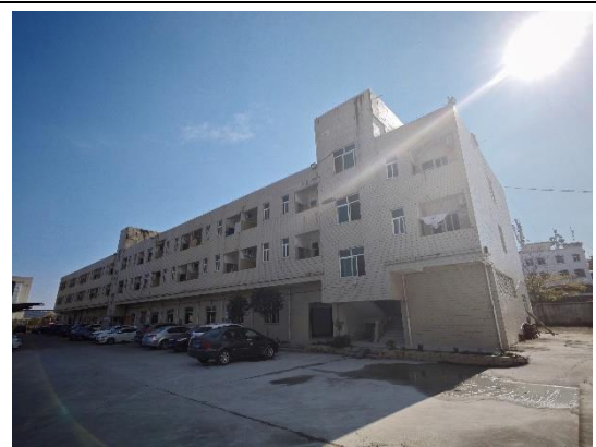
工业楼整体照片
